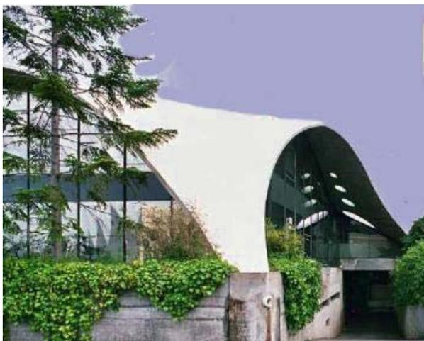
*En 1968, l'entreprise SICLI emménage aux Acacias dans une nouvelle usine recouverte d'un spectaculaire voile en béton précontraint*
